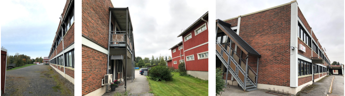
Kuva 11. Virastotalo jokirannan puolelta sekä kaakkoissivu, jossa portaikko (Ramboll 09/2023).
