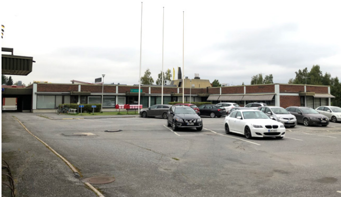
Kuva 12. Kunnan virastotalon sisäpihaa tontinrajalta kuvattuna (Ramboll 09/2023).
